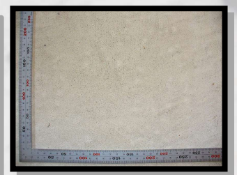
スーパーラックレスを使用したコンクリートの表面状況
